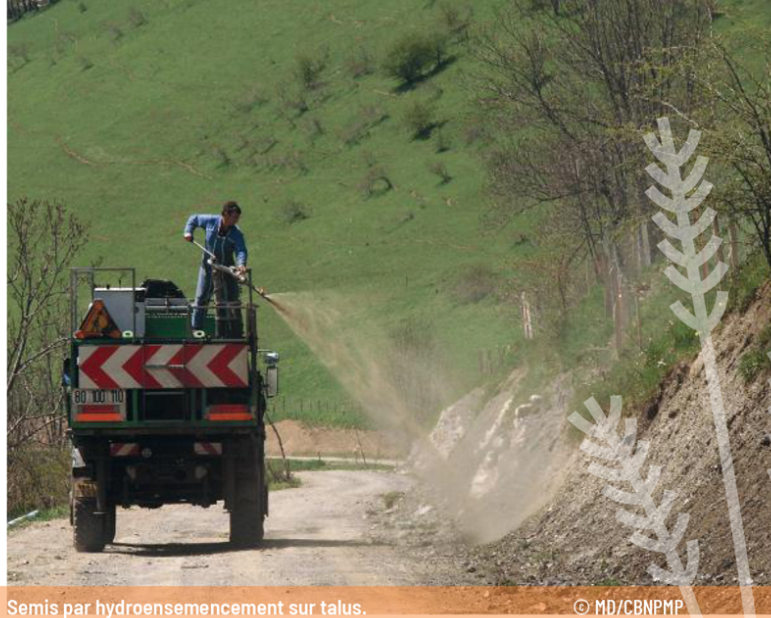
Semis par hydroensemencement sur talus.
