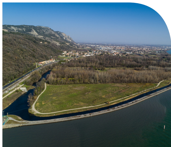
Vue aérienne prise par drone du parc à boutures CNR de l'île de Bland, Novembre 2021. Crédit : CNR
